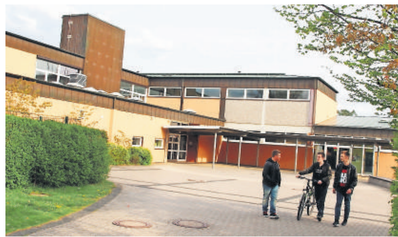
Die jetzige Hauptschule verschmilzt 2018 mit der Realschule zu einer Oberschule und zieht ebenfalls auf die andere Straßenseite um.
